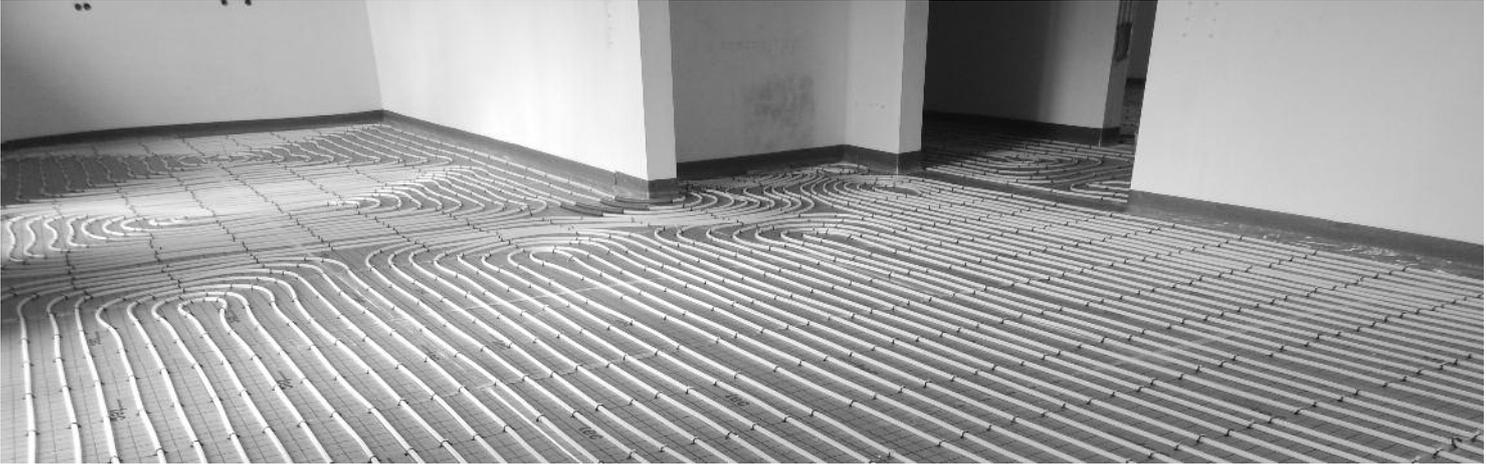
Die protec Rollbahnen und Faltpplatten mit aufkaschierter Bändchengewebefolie sind die Grundelemente des Tackersystems. Sie dienen zur Wärmedämmung sowie als Rohrträgerelemente. Die auf der Folie aufgedruckte Rasterung ermöglicht das Ausrichten der Heizrohre auf der Fläche, die dann mittels der protec Rohrclips sicher in der protec Bändchengewebefolie arretiert werden.
