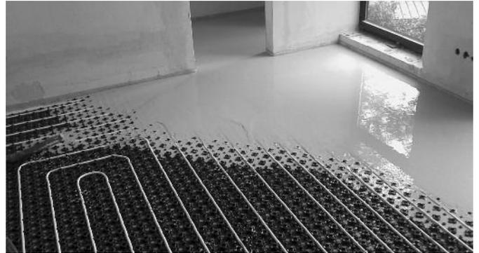
Durch die geringe Estrichüberdeckung der protec Heizrohre findet eine schnelle Wärmeübertragung an den Raum statt. Diese ermöglicht eine besonders wirtschaftliche Nutzung des Systems und erhöht das Reaktionsverhalten bei wechselnden Temperaturen. Zur gleichmäßigen, homogenen Erwärmung der Flächen empfehlen wir die protec Heizrohre in einem engen Rohrabstand (10 cm oder 15 cm) zu verlegen um somit mittels geringer Vorlauftemperatur eine gleichmäßige Wärmeabgabe an den Raum zu erzielen.
