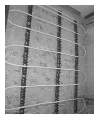
**Wandheizung** als Schienensystem mit Nassputzüberdeckung
